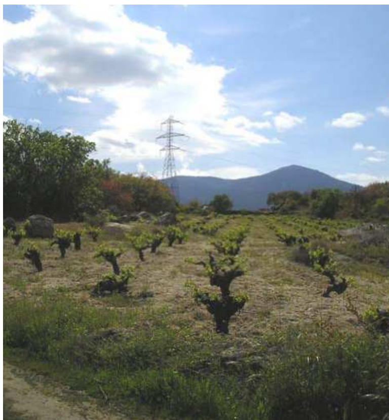
Imagen 10: Línea de 132 kV de doble circuito
