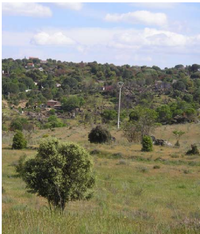
Imagen 12: Línea de 15 kV
