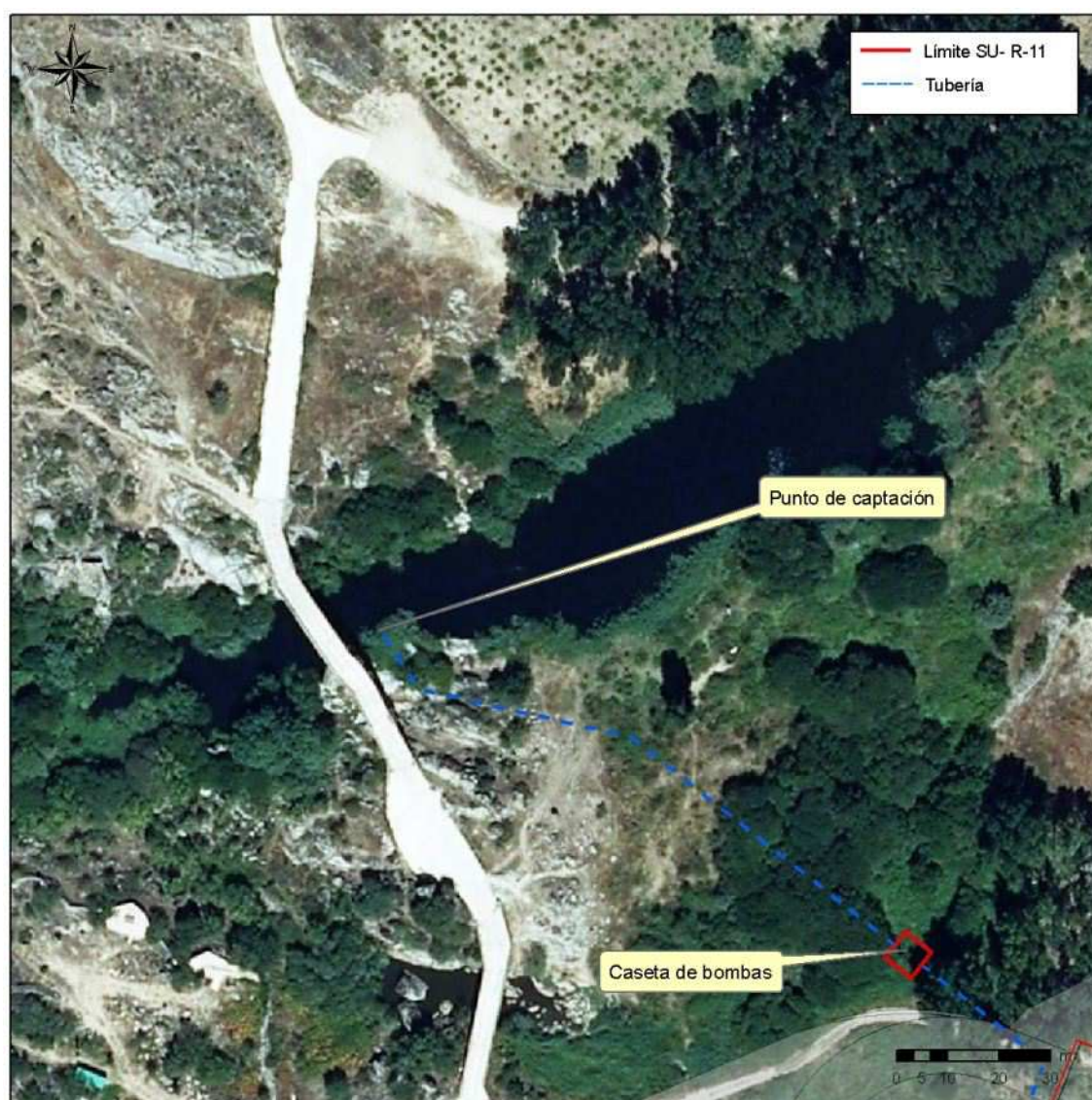
Imagen 95: detalle de la vegetación presente en el punto de captación de agua para abastecimiento y caseta de bombeo
